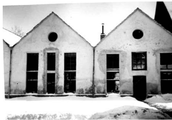
Abb. 2005-2-08/010 Alte Glashütte Köflach [Erstes Steiermärkisches Tafel- und Hohlglashüttenwerk Parlow & Hart], Magazin im rechten Gebäude amtierte Gustav Parlow aus Dokumentation Guß / Parlow
