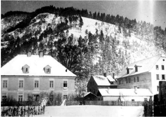
Abb. 2005-2-08/008 "Parlowhaus", rechts Werkswohnhäuser Hohes Haus [Erstes Steiermärkisches Tafel- und Hohlglashüttenwerk Parlow & Hart] aus Dokumentation Guß / Parlow
