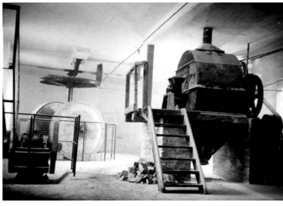
Abb. 2005-2-08/013 Alte Glashütte Köflach [Erstes Steiermärkisches Tafel- und Hohlglashüttenwerk Parlow & Hart] Kollergang, Steinbrecher, Kugelmühle aus Dokumentation Guß / Parlow
