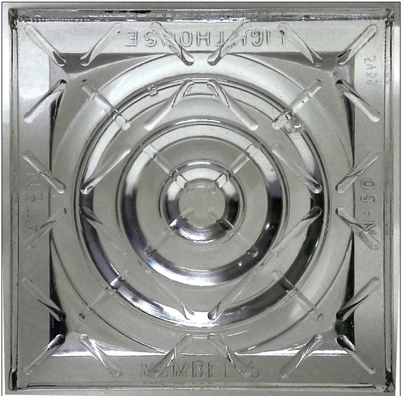
Abb. 2017-1/17-01; Glasbaustein für die Beleuchtung von Räumen in Geschossen unter begehbaren / befahrbaren Flächen, Oberseite (die Schrift wurde auf der Unterseite seitenverkehrt eingepresst, so dass man sie auf der Oberseite lesen kann!)
