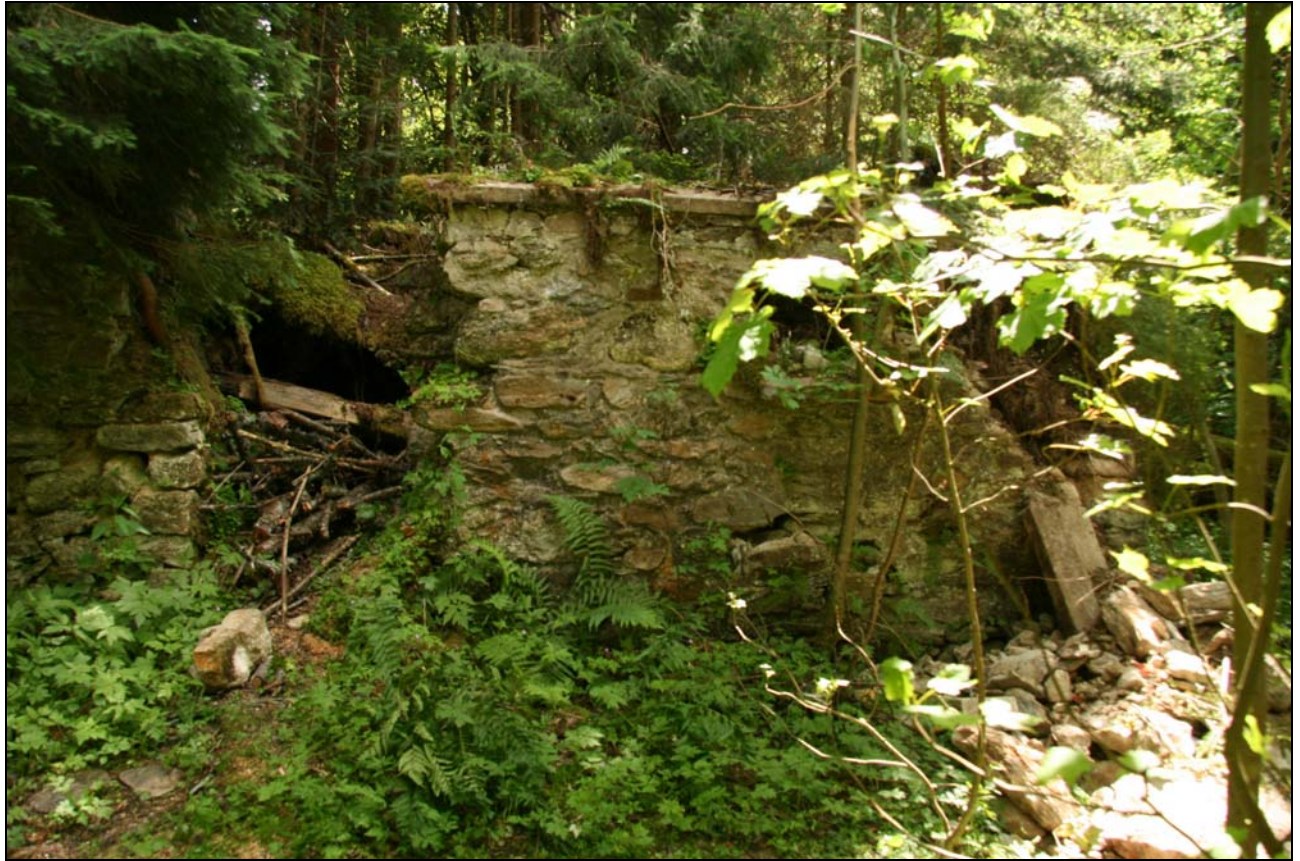
Abb. 2016-1/05-04; Ruinen der Arbeiterhäuser der Neu-Osserhütte, Foto Günther Haller 2014
