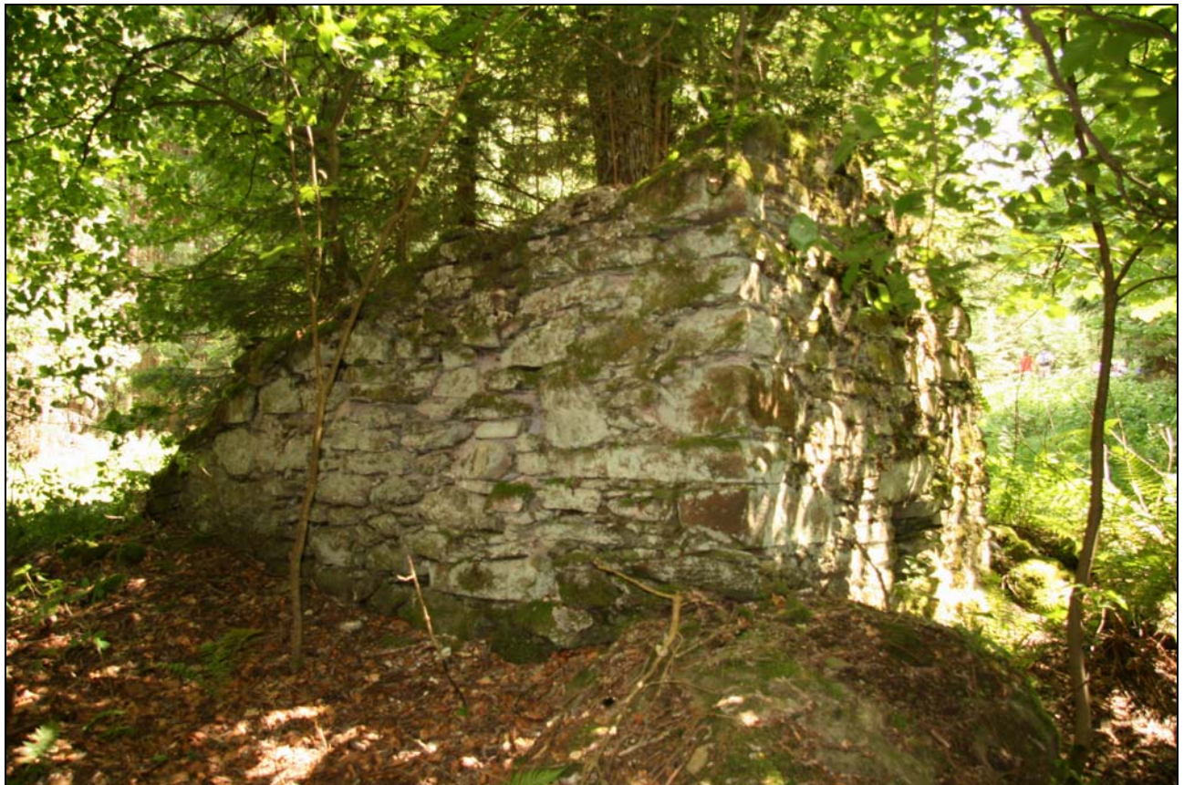
Abb. 2016-1/05-01; Ruinen der Arbeiterhäuser der Neu-Osserhütte, Foto Günther Haller 2014
