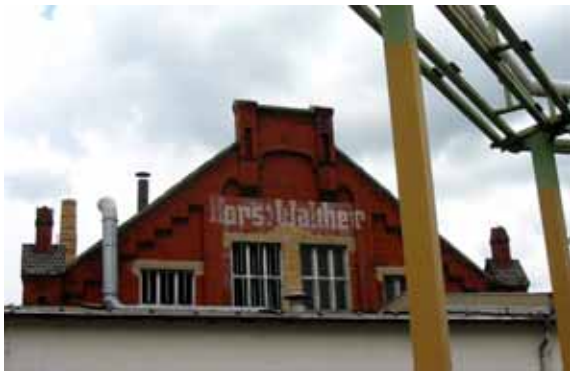
Abb. 2004-3/508 Glaswerk GLASAX GmbH in Schwepnitz alte Glaswerkshalle von Horst Walther
